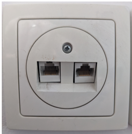
Obrázek: Zásuvka s RJ-45 keystone na „na zdi“ PŘF (ABB Swing)
